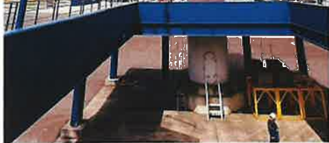
船上に据え付けられるデッキクレーン。鉄の囲いで船を再現している
