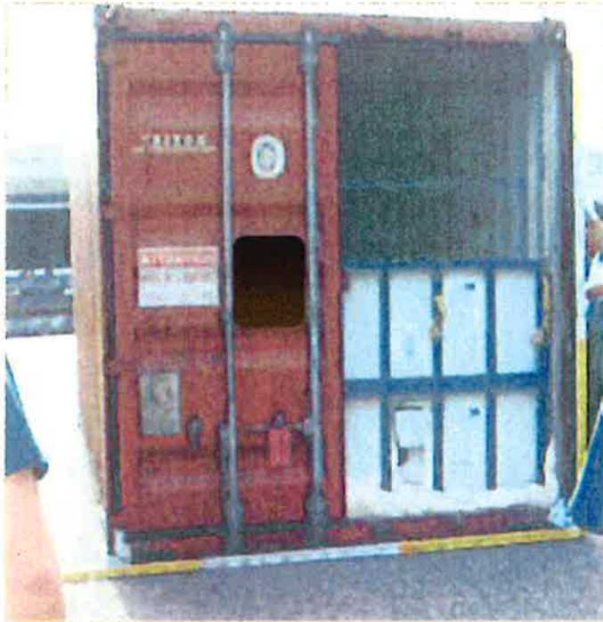
写真1 コンテナ内部の状態
