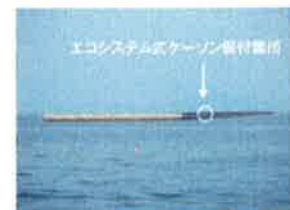
エコシステム式ケーソン据付箇所
