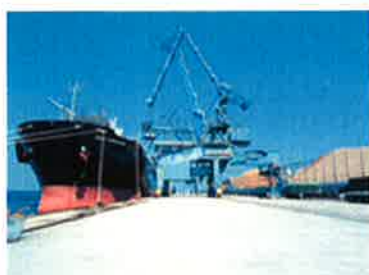
村松地区の西側の一15m岸壁からは製紙の原料が荷揚げされる
